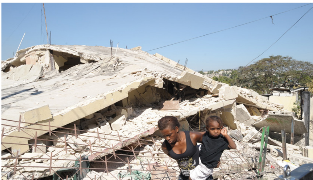
Figura 4: Secuelas del terremoto de magnitud 7,0 de 2010 en Haití
