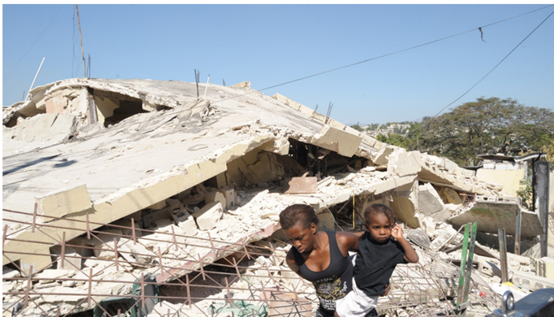
Рисунок 4: После землетрясения магнитудой 7,0 баллов на Гаити в 2010 году
