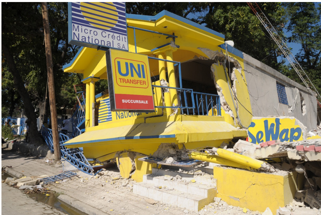
Рисунок 11: Разрушенное здание агентства микрокредитования после землетрясения 2010 года в Гаити
