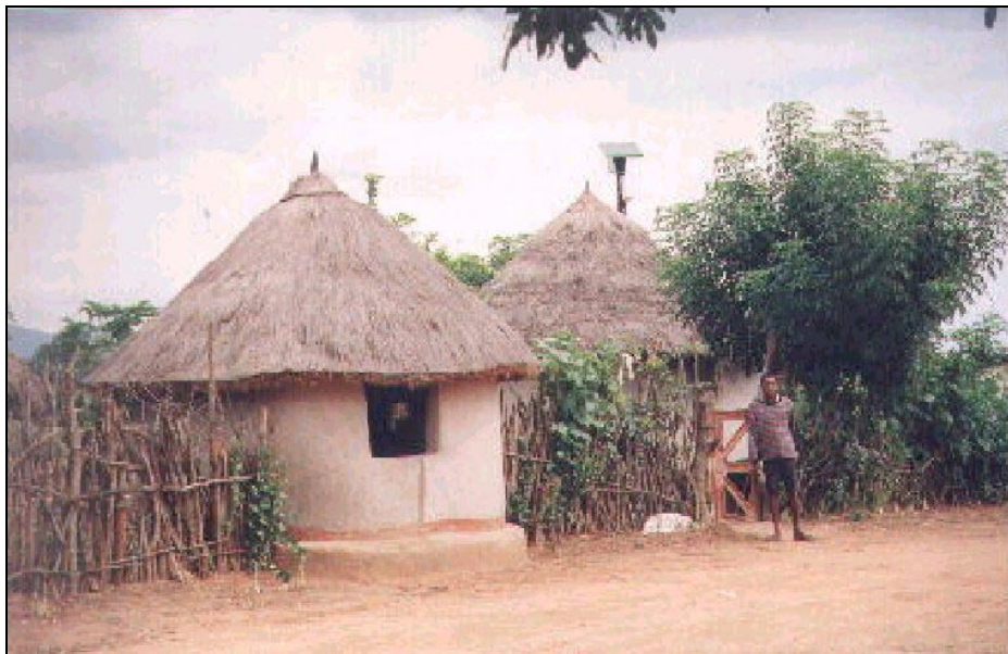
Figure 4.7 – Boucle locale hertzienne en République sudafricaine (Un panneau solaire sert à alimenter l'équipement d'abonné)
