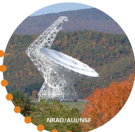
位于美国西弗吉尼亚的100米Robert C. Byrd Green Bank射电望远镜。在《无线电规则》的保护下，该现代化的射电望远镜能够观测21厘米的H I线。
