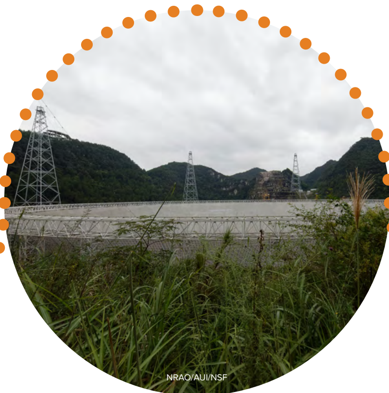
Сферический радиотелескоп с пятисотметровой апертурой (FAST, г. Цяньнань, провинция Гуйчжоу, Китай). Частоты работы – от 70 МГц до 3 ГГц.
