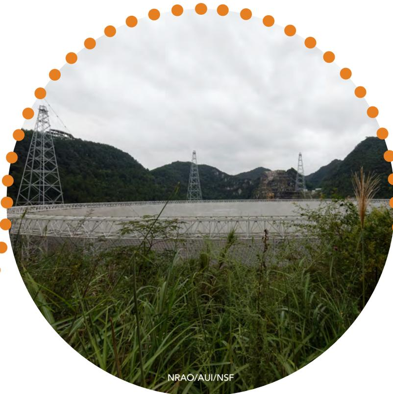
El Telescopio de Apertura Esférica o FAST (por sus siglas en inglés) en Qiannan, Guizhou (China), un radiotelescopio de quinientos metros de diámetro que permite observar el espectro entre 70 MHz y 3 GHz.
