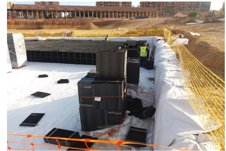
Depósito de infiltración en el Parque Central
