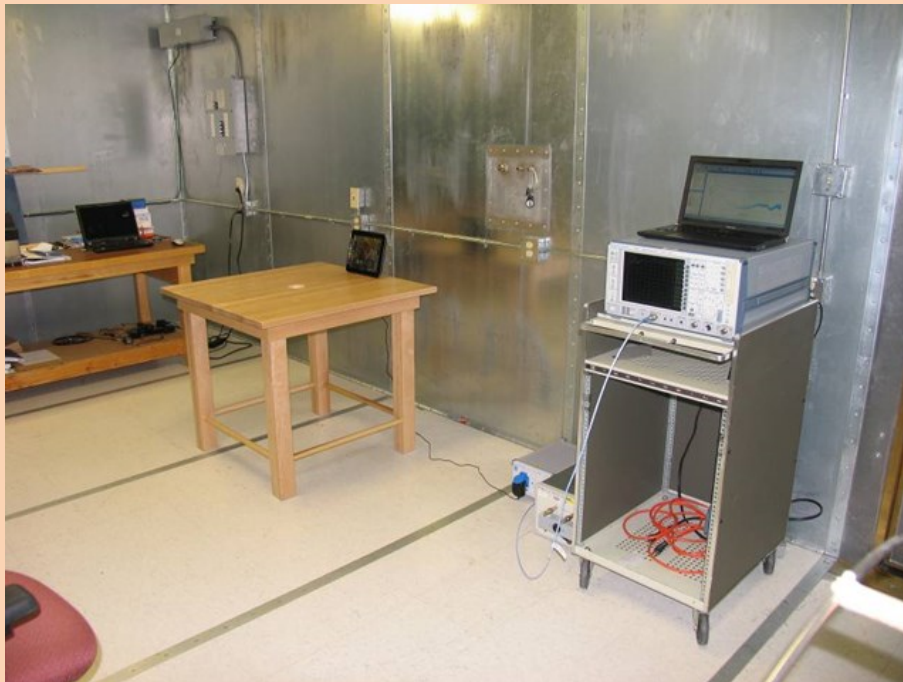
Figure 14: Intérieur d'une chambre blindée
