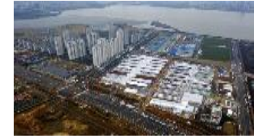
Cobertura de zonas de emergencia
