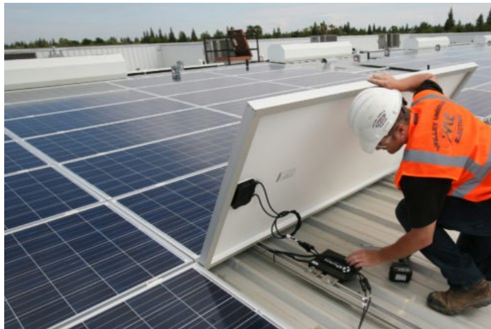
Рисунок 6. Подключение микроинвертора к солнечной панели [16]
