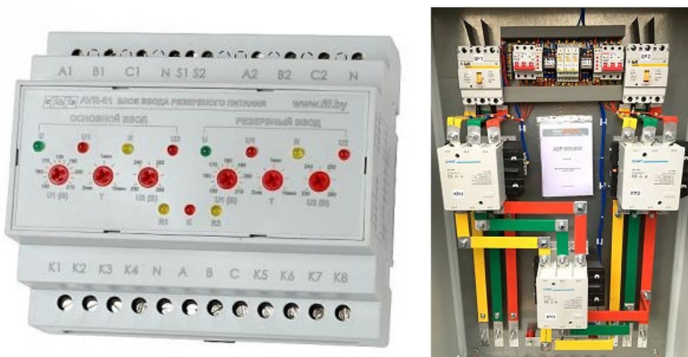
Рисунок 33. Контроллер АВР (слева) и щит АВР (справа)
