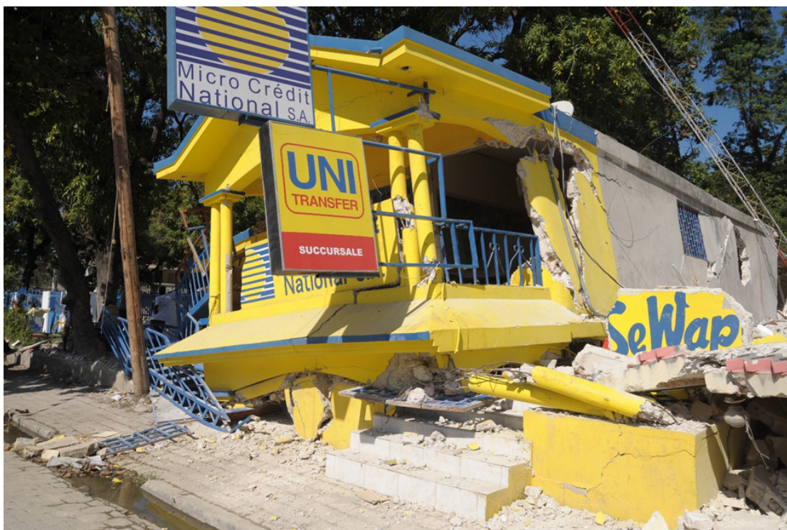
Figure 11: Un bureau de micro-crédit hors service à Haïti après le tremblement de terre de 2020.
