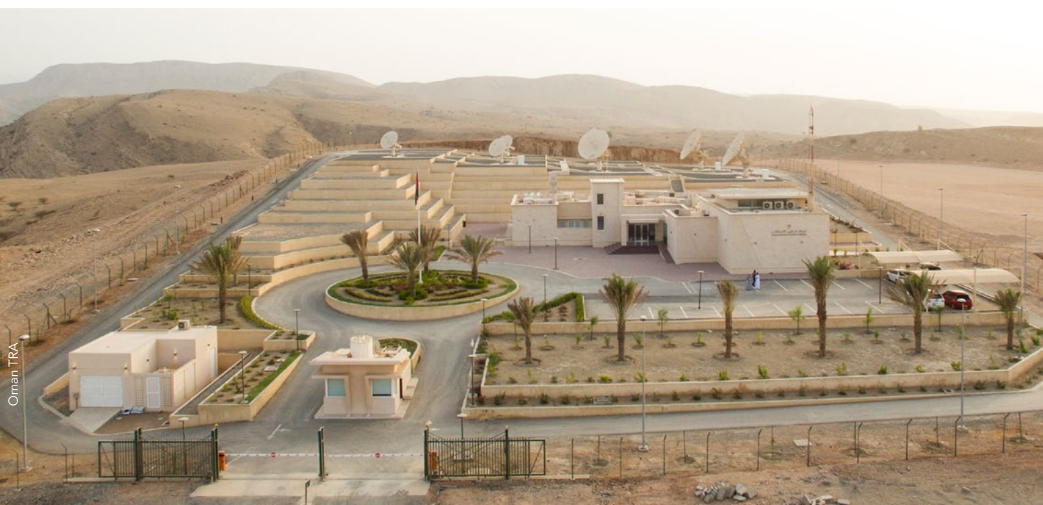
Центр управления станции контроля космической радиосвязи в Маскате (Оман)
