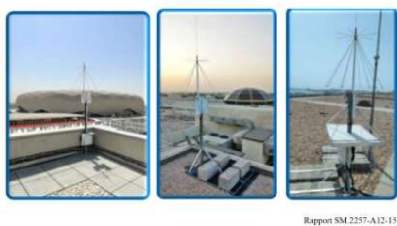
FIGURE A12-15 Configurations des installations TDOA sur les toits (exemples)
