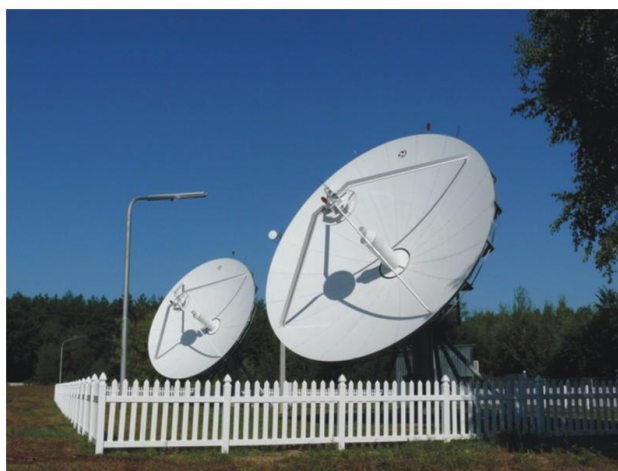
Антенная система станции спутникового радиоконтроля УГЦР
