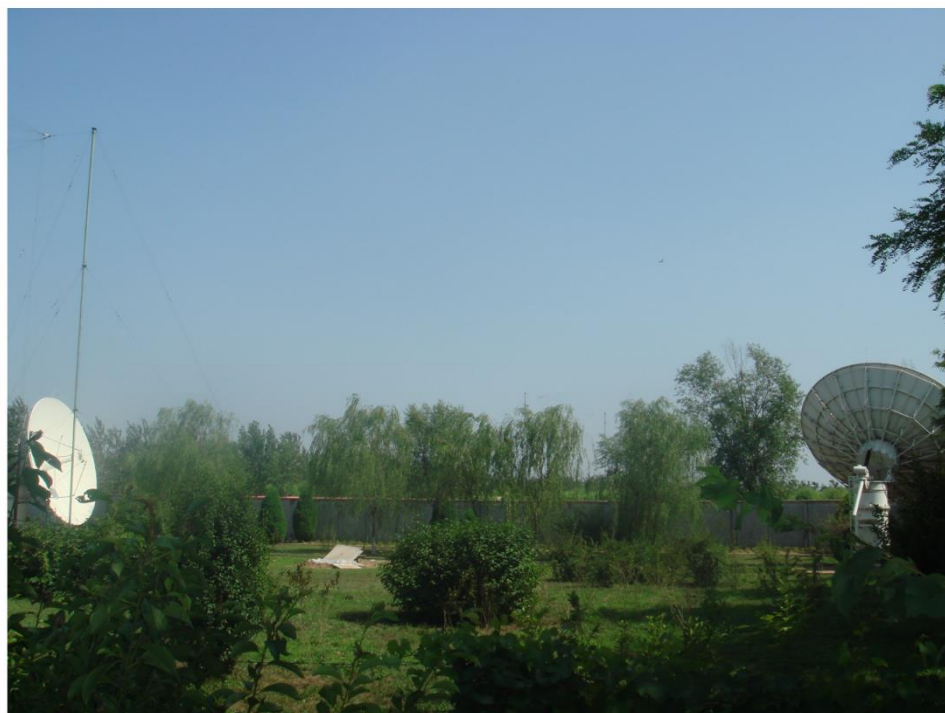
FIGURE 3 Deux antennes de secours de 7,3 m
