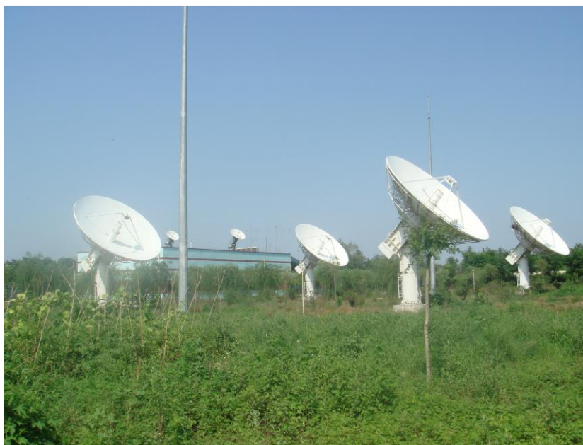
第二套系统的四副直径7.3米天线 和参考源发射天线（屋顶上）
