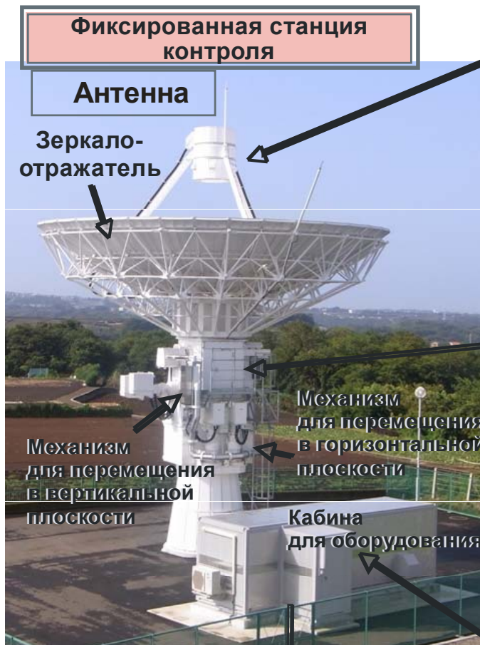
Конфигурация антенны диаметром 13 м
