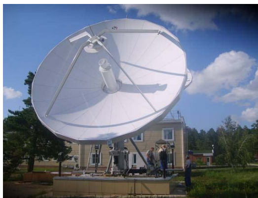
Антенная система с диаметром антенны 7,3 м
