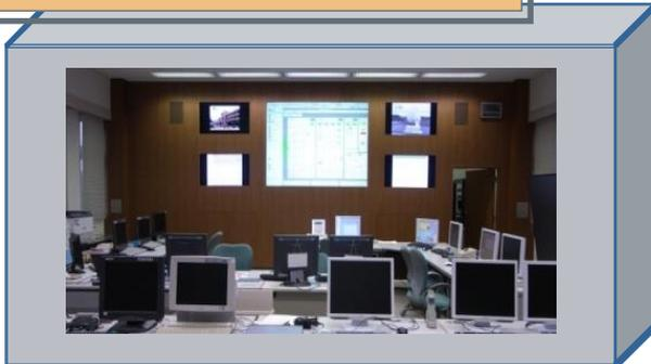
Equipado con procesadores de funcionamiento, registradores de datos y dispositivos para el control del funcionamiento y las actividades de comprobación técnica del sistema. La recepción/medición de las ondas radioeléctricas en la estación fija de comprobación técnica se controla mediante el funcionamiento y supervisión de los terminales de control.
