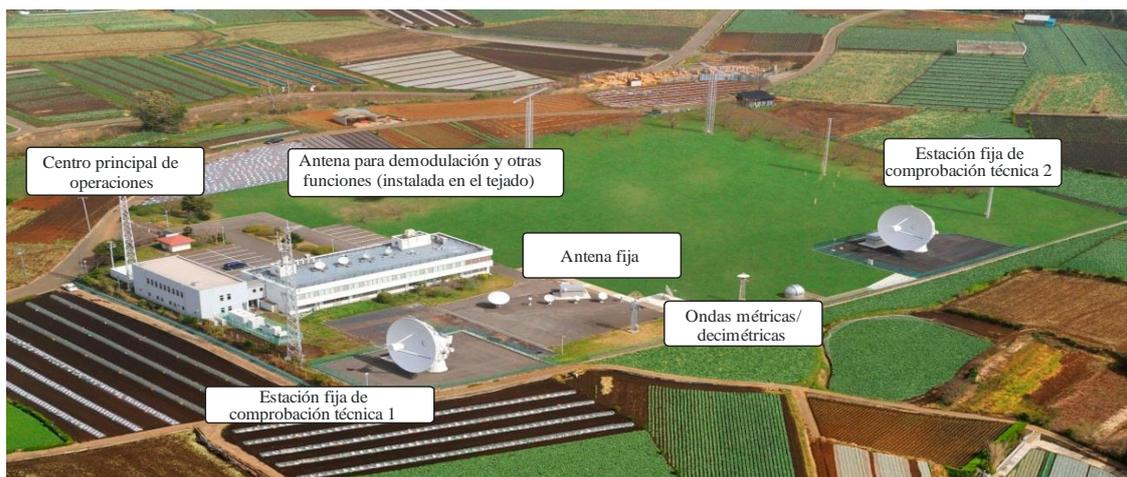
– **Estación fija de comprobación técnica 1 y 2 (multibanda L, S, C, Ku, Ka)**
