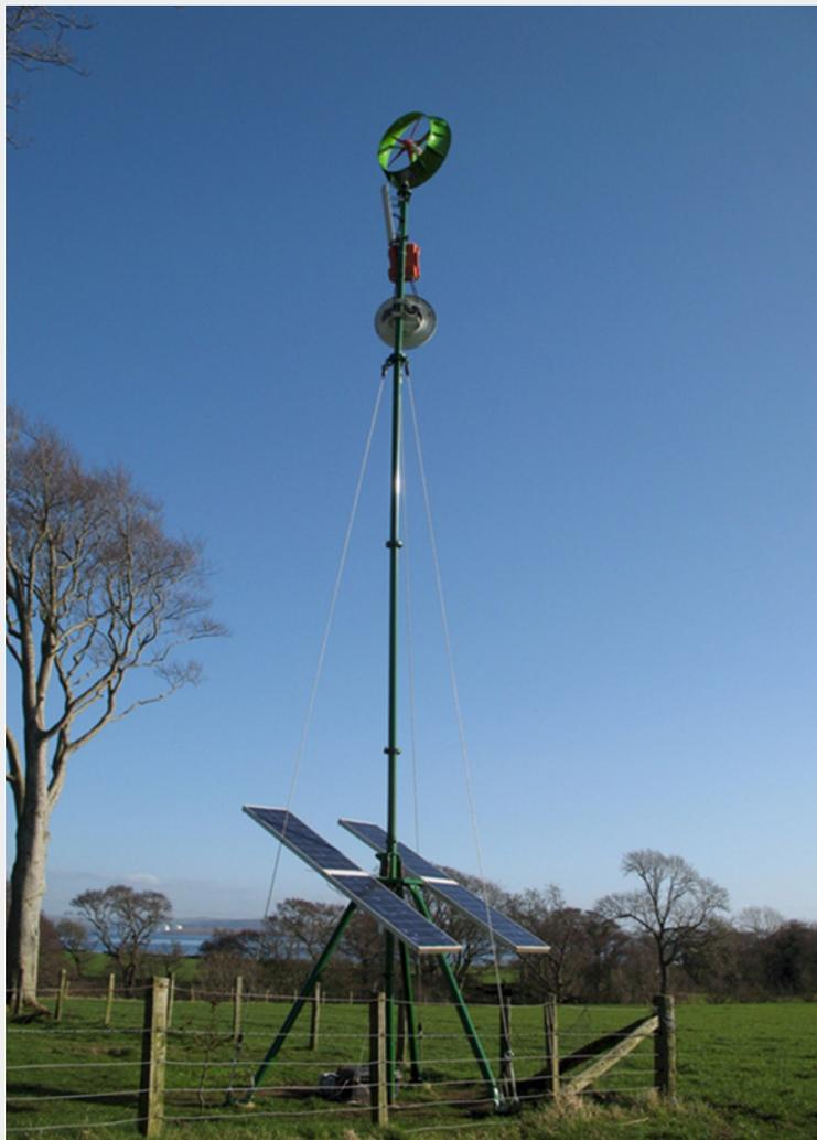
Прототип базовой станции WindFi на острове Бьют, Шотландия. Базовая станция состоит из солнечных панелей и аккумуляторных батарей, над которыми на 10-метровой мачте расположена ветряная турбина с антеннами и радиоборудованием непосредственно под ней.
