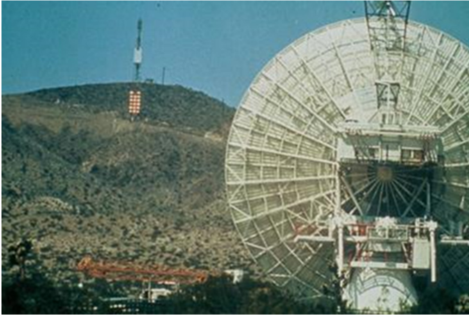
图29：使用26 m抛物天线和450 kW、2.388 GHz速调管作为发射机和3.4 × 7.2 m整流天线阵作为接收机进行的1英里点对点电力传输实验
