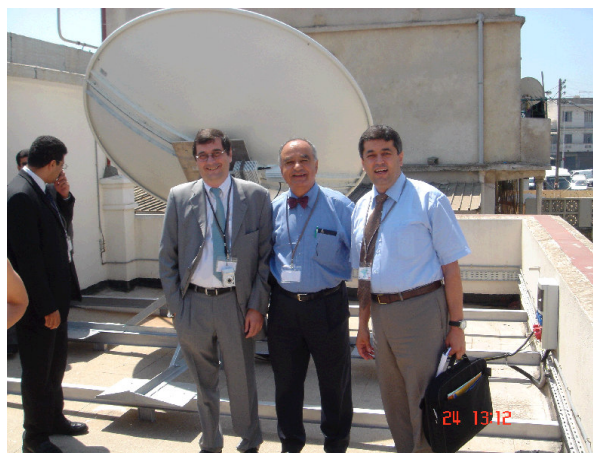
Рисунок 5 – Параболическая спутниковая антенна, установленная на крыше здания ISTEM в университетском городке Сара
