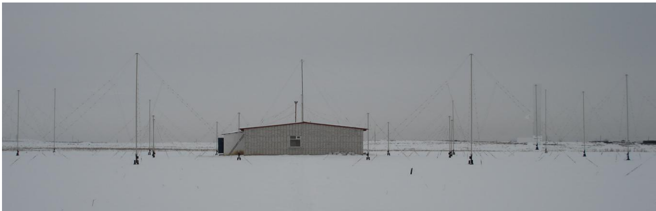
Рисунок 2. Внешний вид АФС и здания обнаружителя-пеленгатора «Восток-ОПК»
