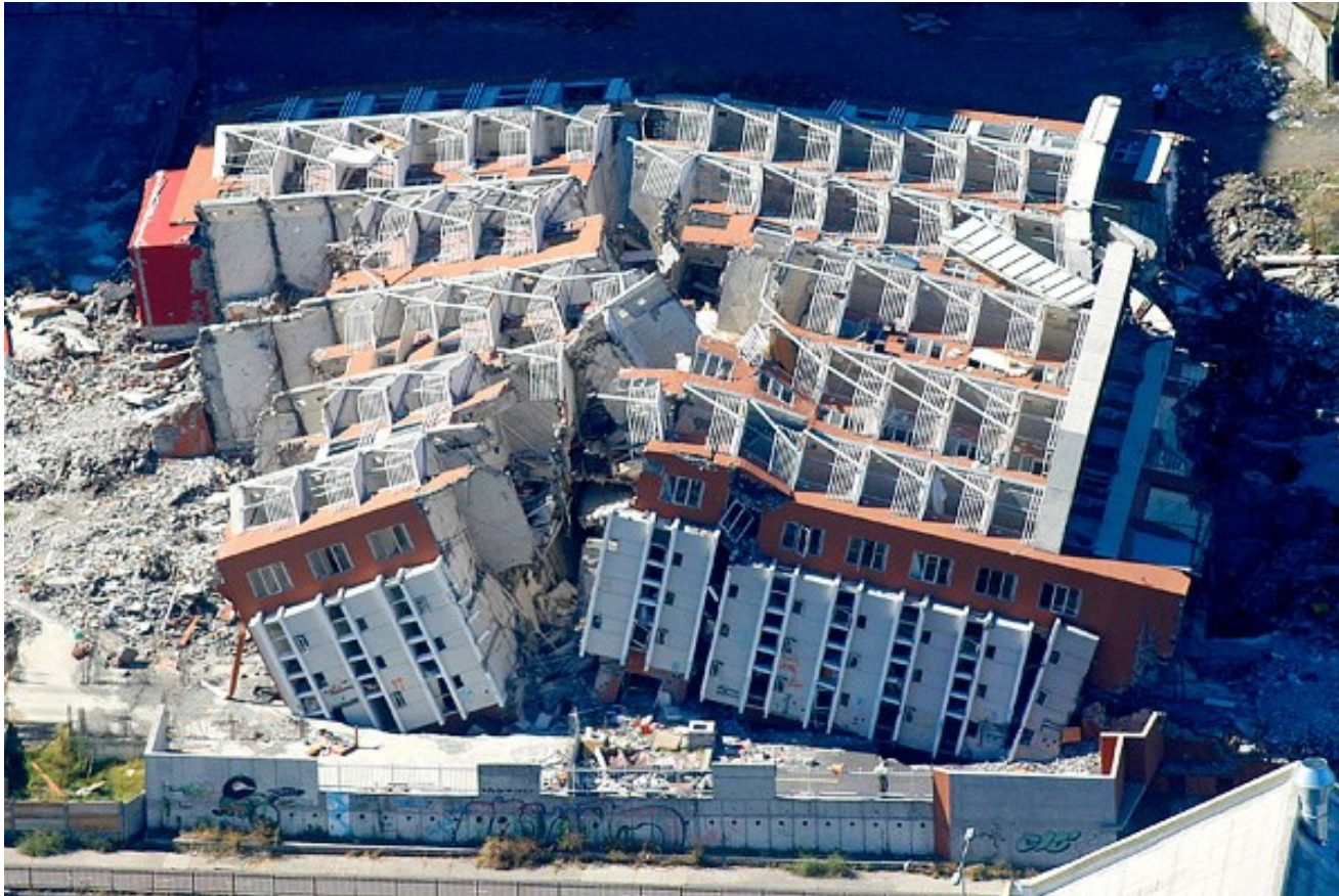
Edificio Alto Río, ciudad de Concepción, Región del Biobío.
