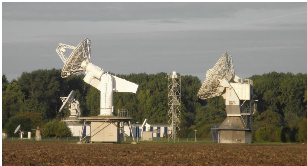
FIGURA 1 Estación de comprobación técnica de Leeheim (Alemania)
