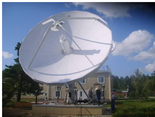
Антенная система с диаметром антенны 7,3 м
