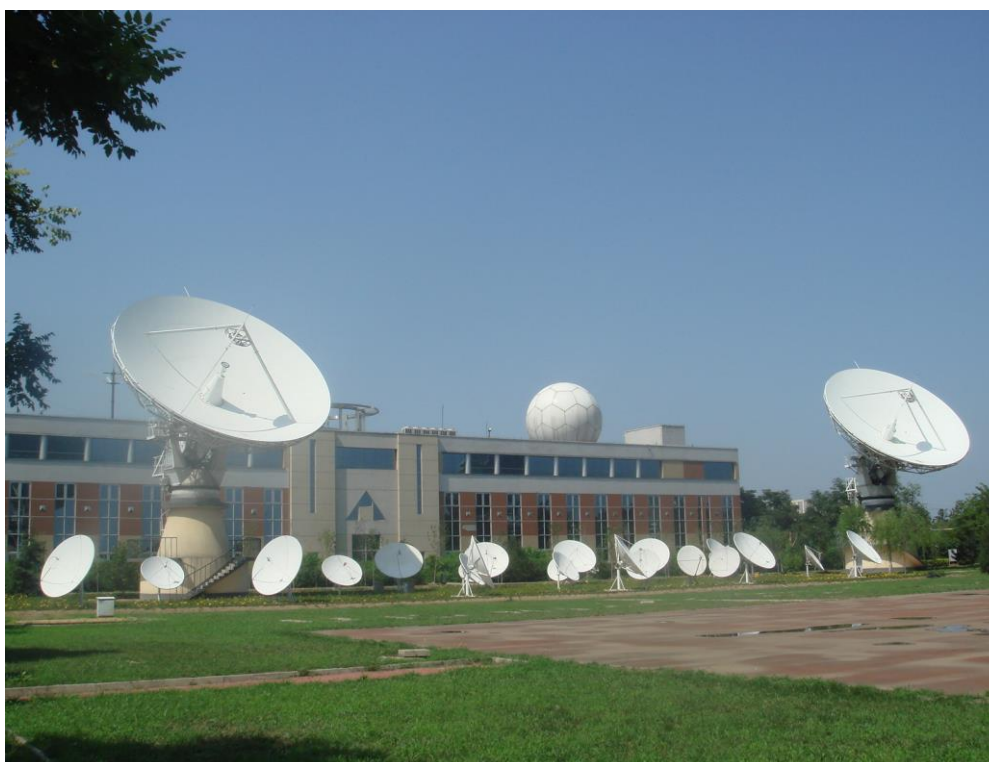
Antennes réceptrices pour le contrôle de la télédiffusion
