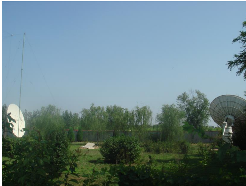
FIGURE 3 Deux antennes de secours de 7,3 m
