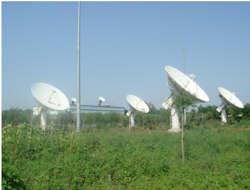
第二套系统的四副直径7.3 m天线 和参考源发射天线（屋顶上）
