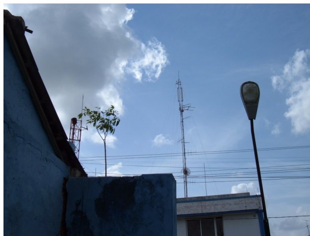
Figura 7.9: Torre en el Centro de Telefonía de Artemisa donde se instaló la antena WiMAX
