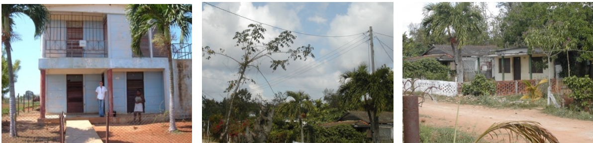
Figura 7.11: Centro médico (oficina) de una familia desde donde se recibe WiMAX y se ha inyectado una señal PLC, línea de cables eléctricos y la vivienda de un usuario
